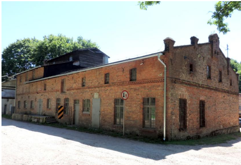
Widok budynku od północy
