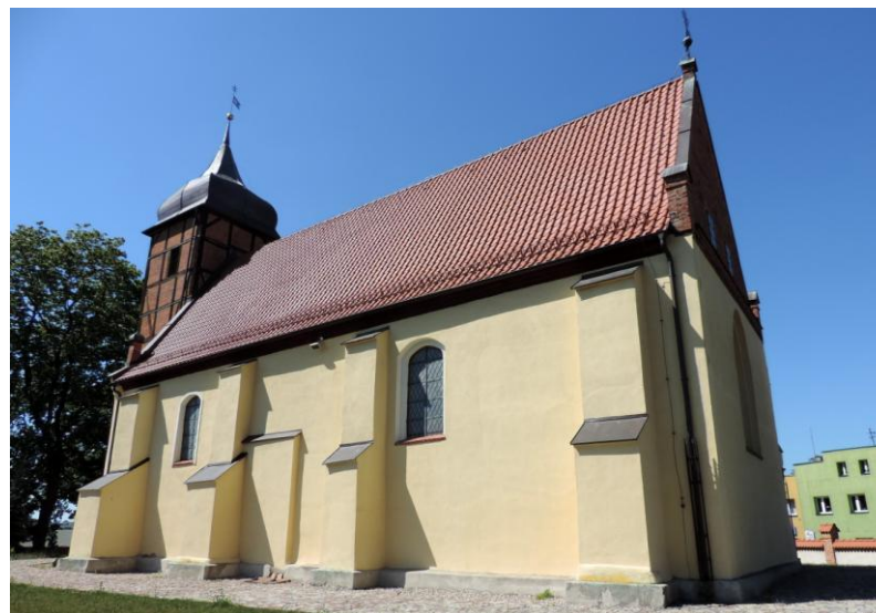
Widok budynku od południowego-wschodu
