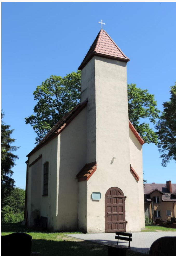
Widok budynku od północnego-zachodu
