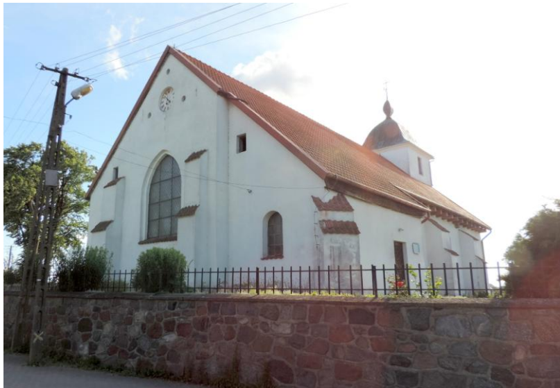
Widok budynku od północnego-wschodu
