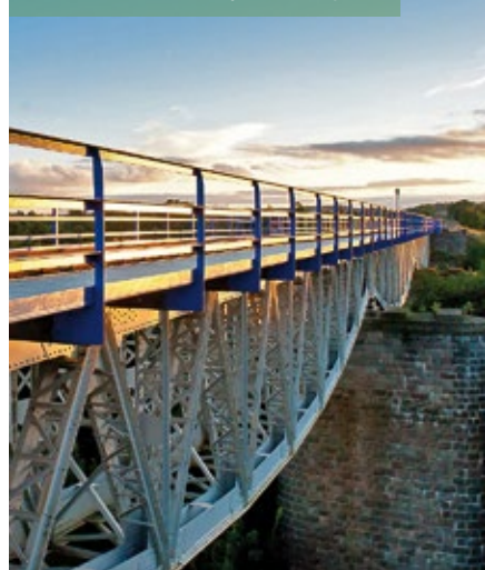
Wiadukt kolejowy nad Słupinią
